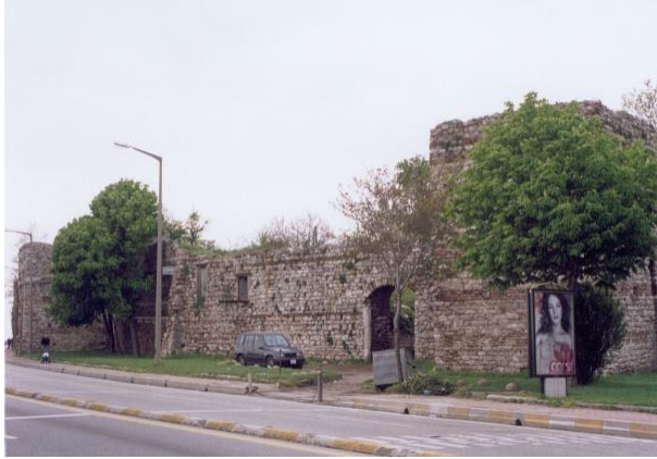
Görsel 4. Sur duvarı, kuleler ve kapı
