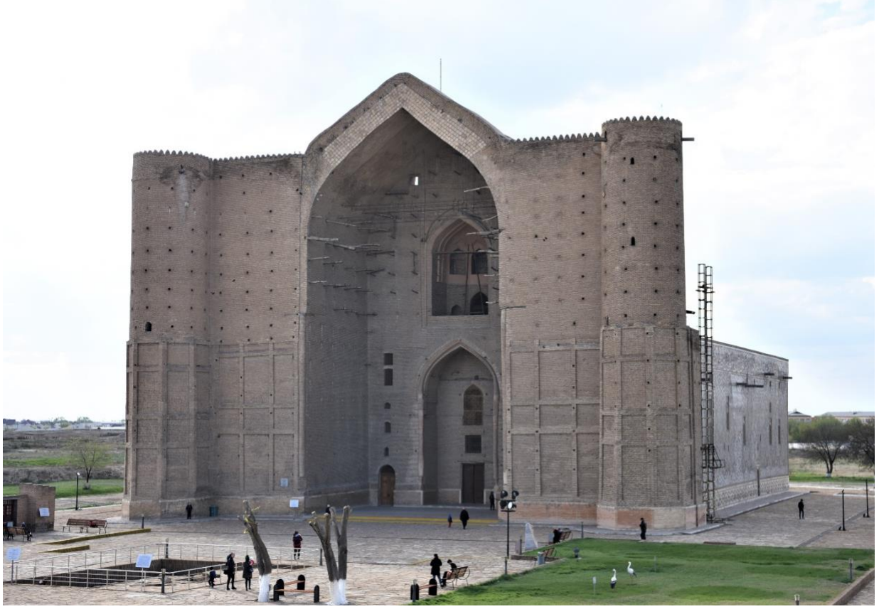
Görsel 1. Giriş Cephesi (Fotoğraf: B. Kabakcı)
