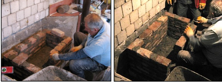
Görüntü 16. Sobanın duvarlarının örülmesi. (Kişisel arşiv)
