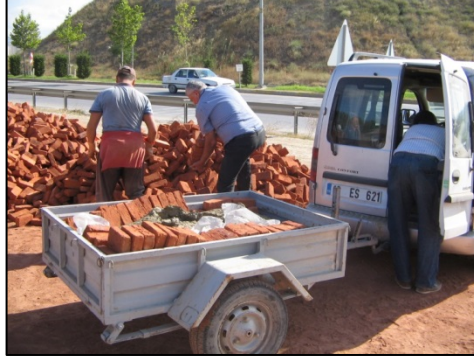
Görüntü 9. Yapımda kullanılacak lime tuğlaların yüklenmesi. (Kişisel arşiv)
