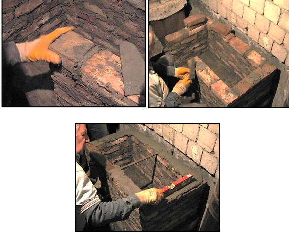
Görüntü 17. Sobanın son sırasının örülmesi ve son gönye kontrollerinin yapılması. (Kişisel arşiv)
