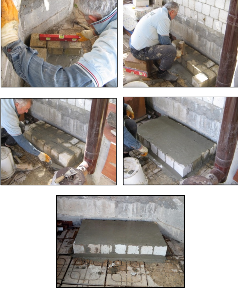
Görüntü 13. Kaidenin yapım aşamaları ve tamamlanmış hali. (Kişisel arşiv)
