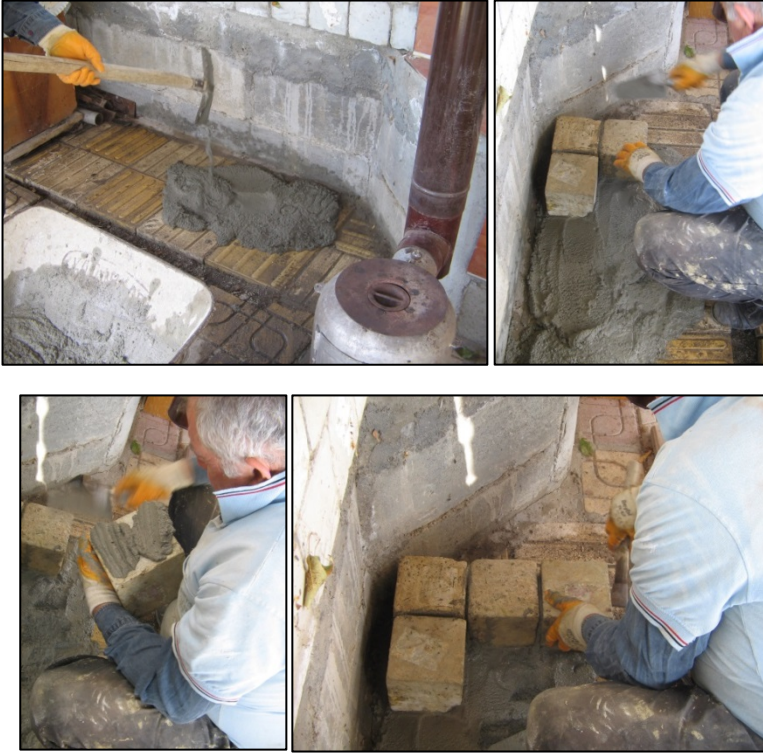
Görüntü 12. Harcın zemine yayılması ve parçaların yerleştirilmesi. (Kişisel arşiv)
