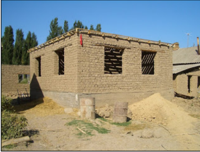
Görüntü 1. Kerpiç yapı.
