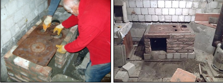
Görüntü 20. Pik döküm plakanın tuğla sobaya yerleştirilmesi.
