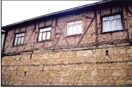
Görüntü 3. Lime tuğlalardan inşa edilmiş isketoz yapı örneği.
